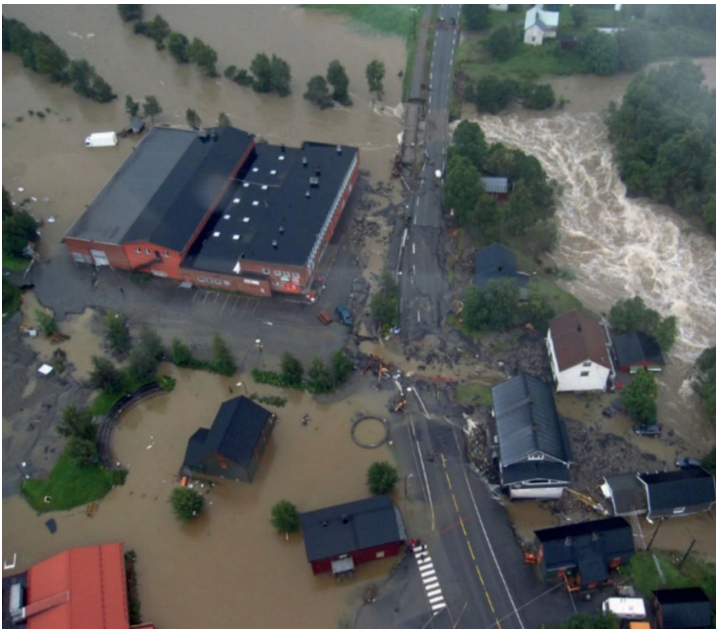
Figur 2-2 Flommen i Ålen i Holtålen kommune i 2011. Brua hadde for liten kapasitet, slik at vannet tok et nytt løp. Foto: Luftforsvaret 330 skvadron.
