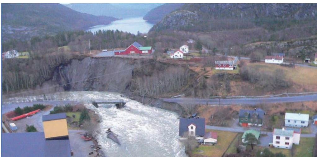
Figur 2-3 Flommen i Lauvsnes i Flatanger kommune i 2006 medførte at elva eroderte i foten av skråningen i yttersvingen, noe som igjen førte til skred i skråningen. Foto NVE.
