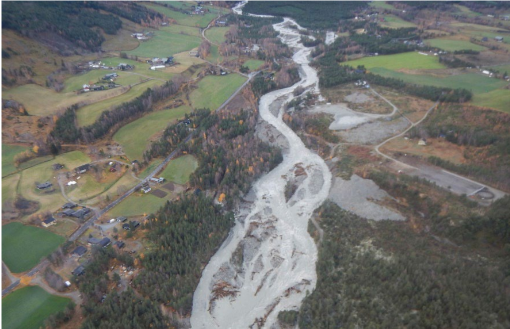
Figur 2-4 Under flommen i Skjølvi i Skjåk kommune i 2018 transporterte elva store mengder løsmasser. Elva la igjen masser i en avstand på mer enn 150 m fra sitt opprinnelige elveløp. Foto: NVE.
