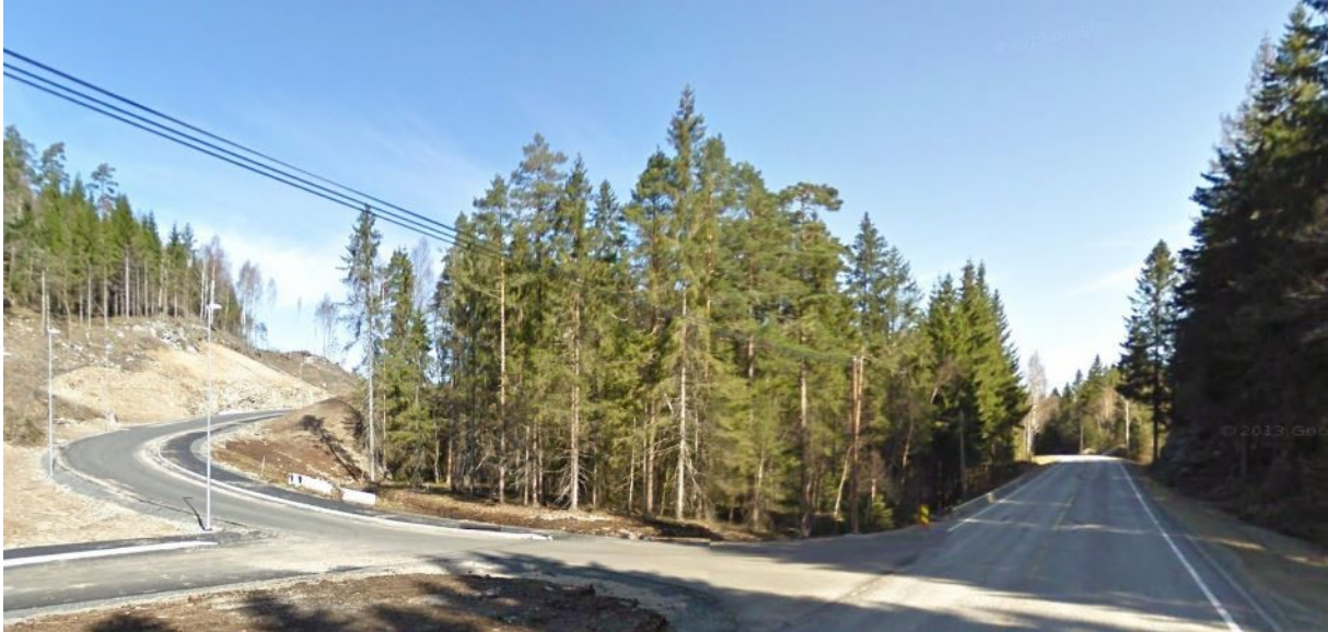
Figur 14, eksisterende kryss fv.402 og Natveitåsen, sett mot nord.
