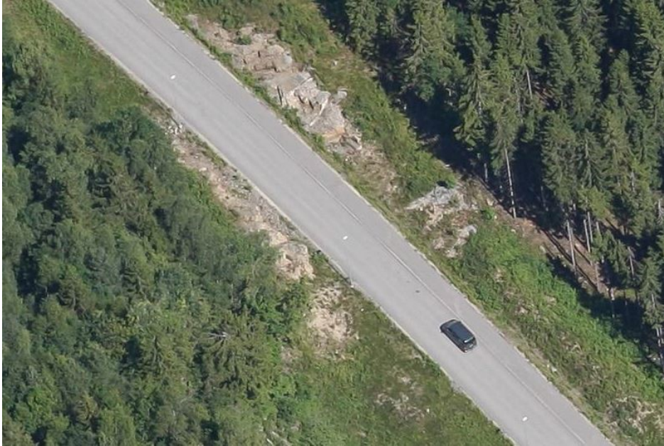
Figur 22, eksisterende kommunal samleveg med g/s-veg (Natveitåsen).
