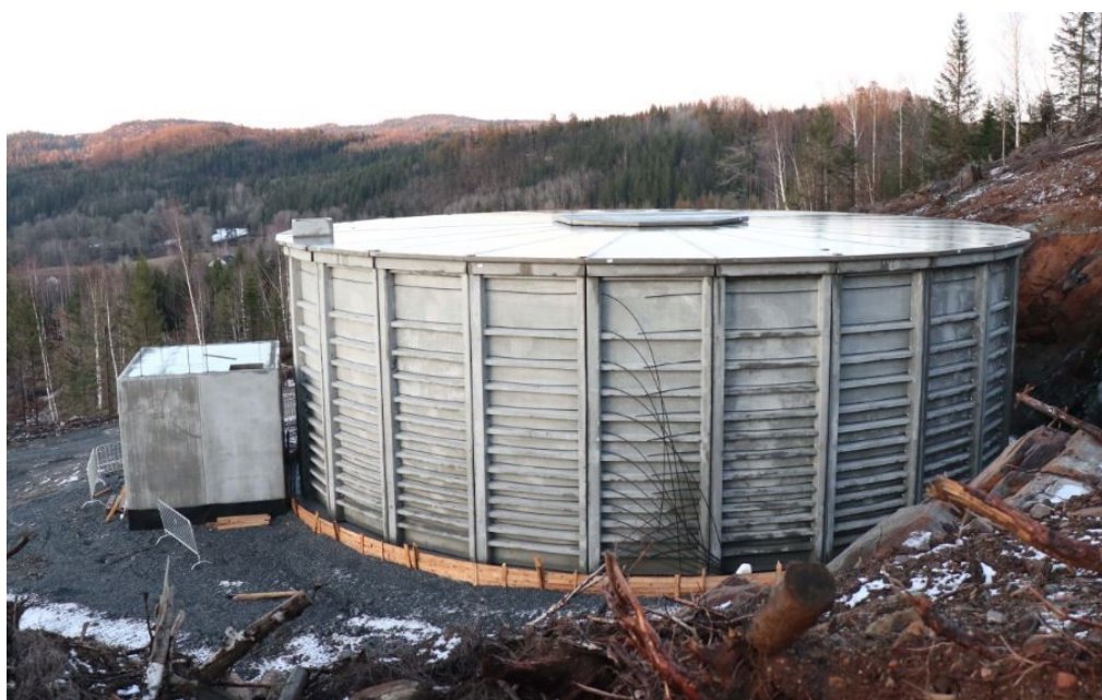
Figur 21, bilde av nytt høydebasseng til vannforsyning.
