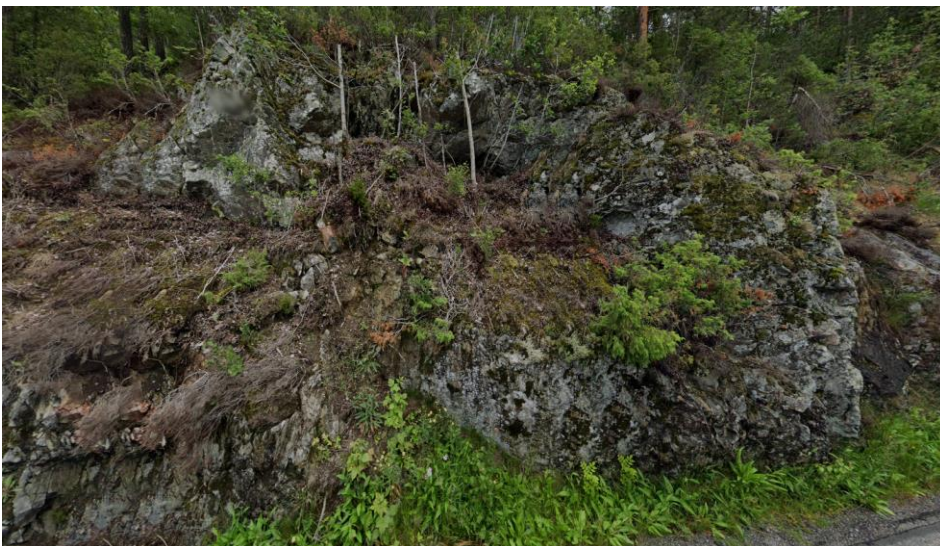
Figur 6: Fjellskjæring i eksisterende vei ved prøvepunkt M2-4. Foto: Google streetview
