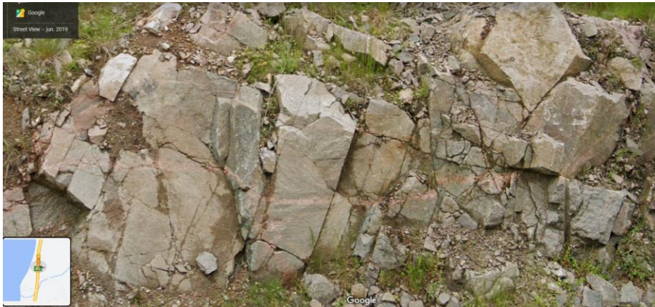
Figur 5: Fjellskjæring i eksisterende vei ved prøvepunkt M1. Foto: Google streetview
