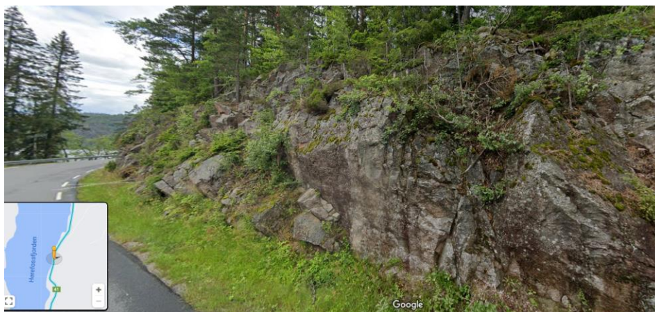
Figur 8: Fjellskjæring i eksisterende vei ved prøvepunkt M10. Foto: Google streetview
