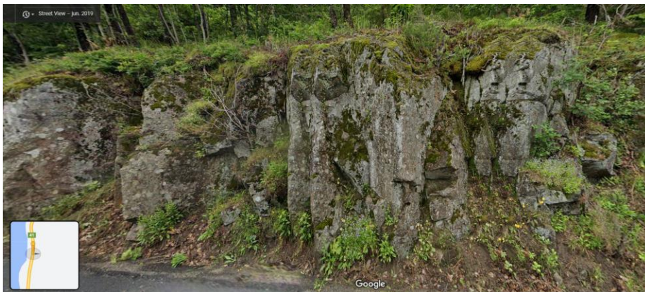
Figur 7: Fjellskjæring i eksisterende vei ved prøvepunkt M7. Foto: Google streetview
