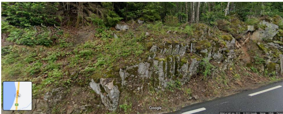
Figur 6: Fjellskjæring i eksisterende vei ved prøvepunkt M6. Foto: Google streetview
