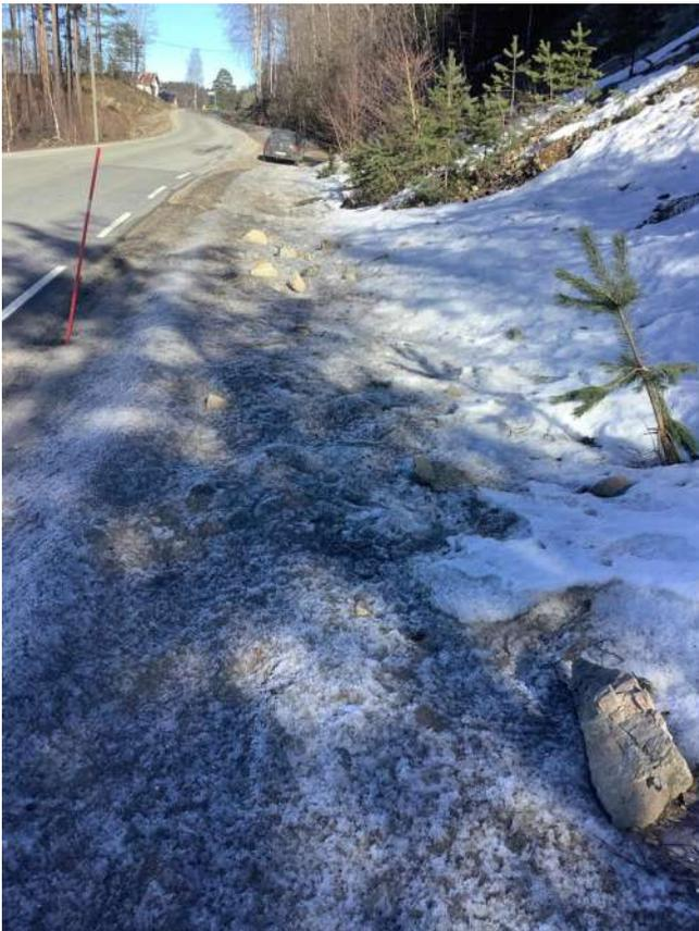
Figur 12: Steinsprang i størrelsesorden 0,1-0,2 m<sup>3</sup> som har nådd grøftkanten mellom ca. profil 115-150. Bildet er tatt mot nord. Fotograf: Ingvild Sangesland.
