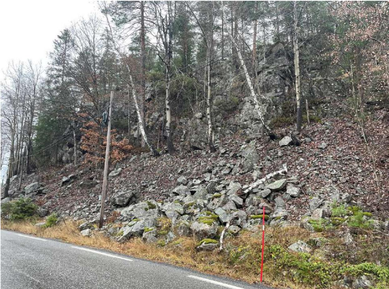
Figur 17: Urmasser med typisk blokkstørrelse ca. 0,1-0,5 m<sup>3</sup> ved ca. profil 720. Bildet er tatt mot nord. Fotograf: Ingvild Sangesland.
