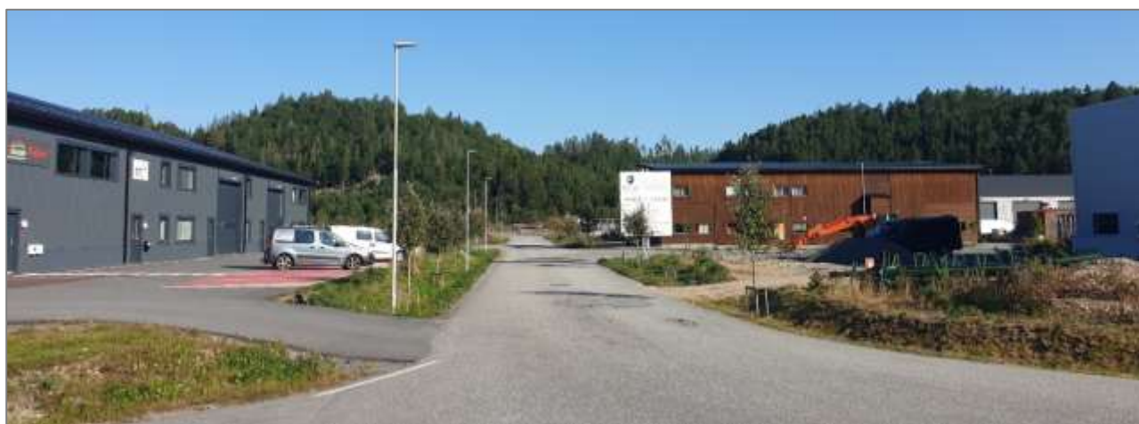
Figur 6. Bebyggelsen ved innkjøringen til næringsområde, med Skaftåsen i bakgrunnen, foto Sweco
