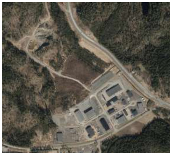
Figur 15. Flyfoto 2020 med anleggsvei og nedsprenget kolle, kilde: kart.1881.no
