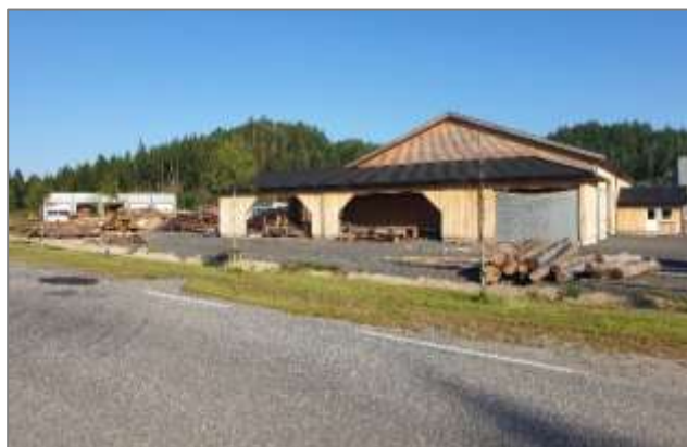
Figur 7. Sagbruket med kledning av tre, foto Sweco
