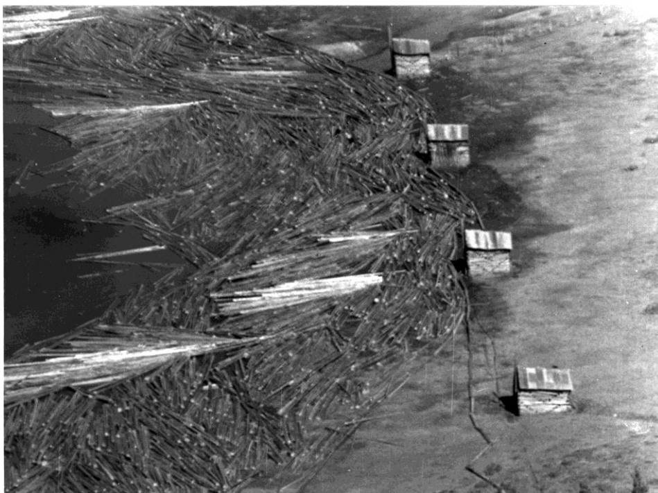
Det ble noen store mengder med tømmer i Flaksvann som ventet på å bli transportert videre. Her ser vi fire av de seks steinfylte bomhusene som holdt Fiansbommen på plass.
