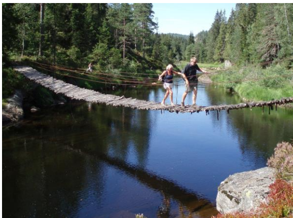
Brua over Vrangefoss i Dige-elva er blitt restaurert.
