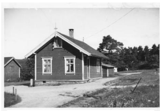
Birkeland stasjon eksisterer ikke lenger.
