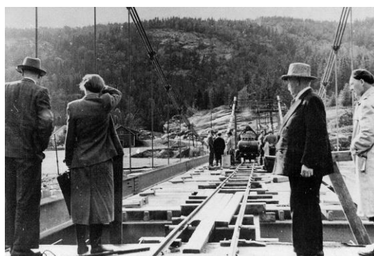
Bygging av Senumstad bru
