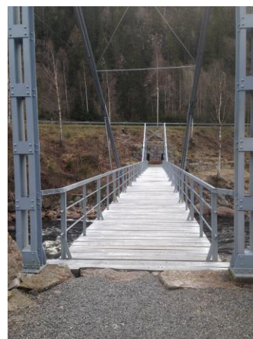
Slettane bru etter restaurering i 2013
