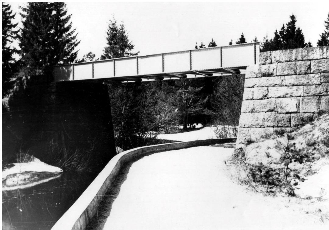
Jernbanebru og viadukt over Osen og Flakkeveien
