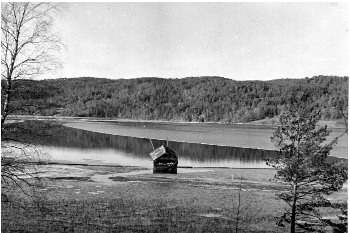
Et av bomhusa som holdt bommen ute fra land i nordenden av Flaksvatn
