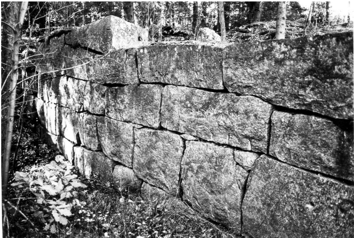
En del av granittgrunnmuren under produksjonsbygget på Flaksvand Dampsag og Høvleri
