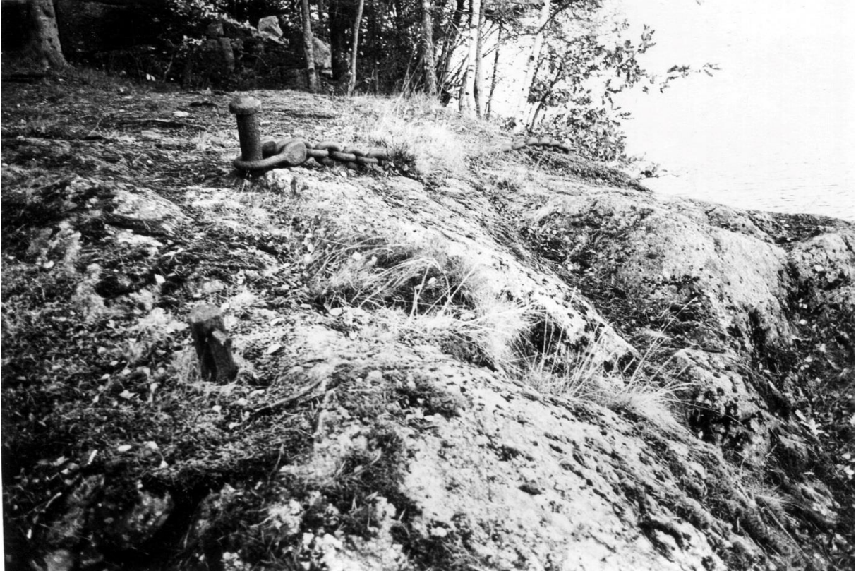
To kraftige jernbolter i fjellodden rett nord for Flaksvand Dampsag og Høvleri. Bolten i bakgrunnen var feste for Sekkebom i Flaksvand. Bolten i framgrunnen var feste for sagbruksbommen
