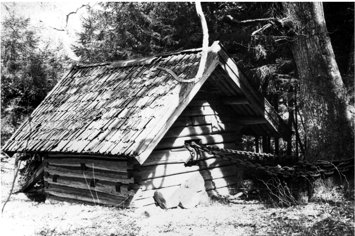
Bomfestehuset for Storebom ved Flaksvatn
