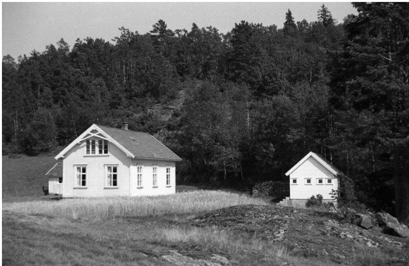
Aas skole tatt i bruk 1901. Grendehus fra 1960.
