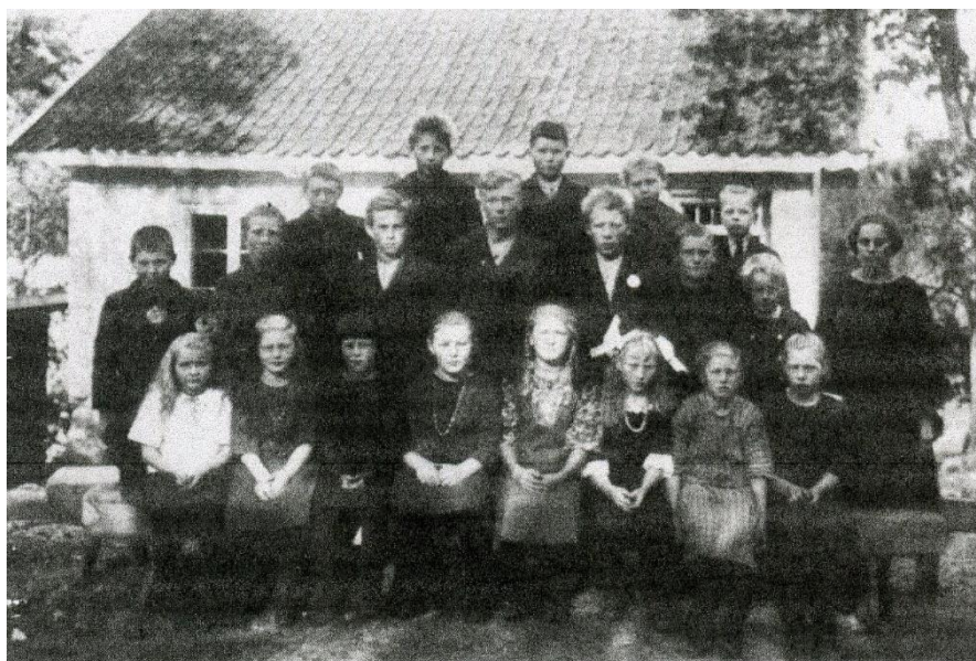
Åmlid skole. Bygd 1876. Det første skolebygg i Herefoss. Bildet er tatt i 1925. Læreren er Marie Holm (Rosåsen) til høyre.
