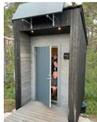
Toalettet ved Kolåsbu er bygget av Herefoss IL på dugnad og ved hjelp av spillemidler og noe kommunalt tilskudd.
