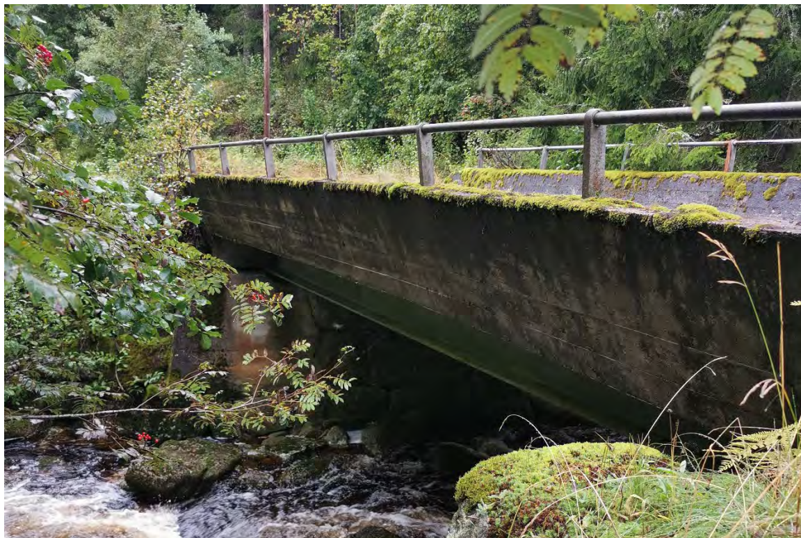
FIGUR 20 BRU PÅ LUNDEVEIEN
