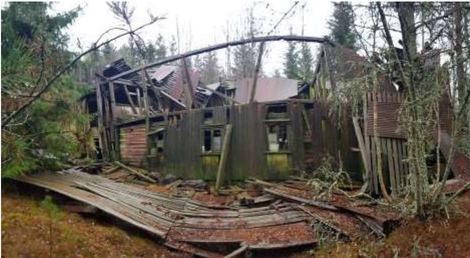
Figur 3-18 Sammenrast driftsbygning, Nordgarden på Gauslå, bnr. 1. Foto: 16. november, Sweco.
