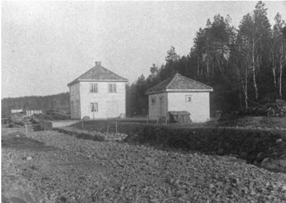
Figur 3-14 Gauslå stasjon under bygging, 1930-tallet. Foto: Leif Blackstad/JMF.
