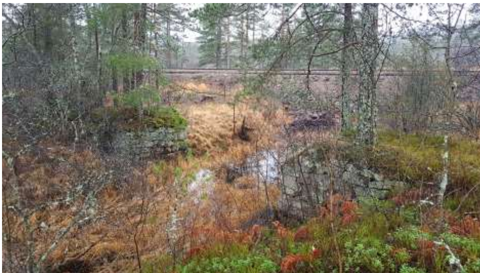
Figur 3-11 Brokar over en bekk, på landstripen mellom Gauslåfjorden og Sundtjønn. Bilderetning V. Foto: 16. november 2021, Sweco.
