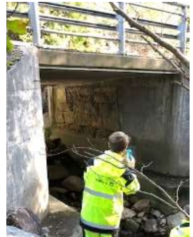
Figur 3-4 Bru/kulvert over Askeåna. Eldre brofundament støpt inn. Foto: 12. november 2021, Sweco
