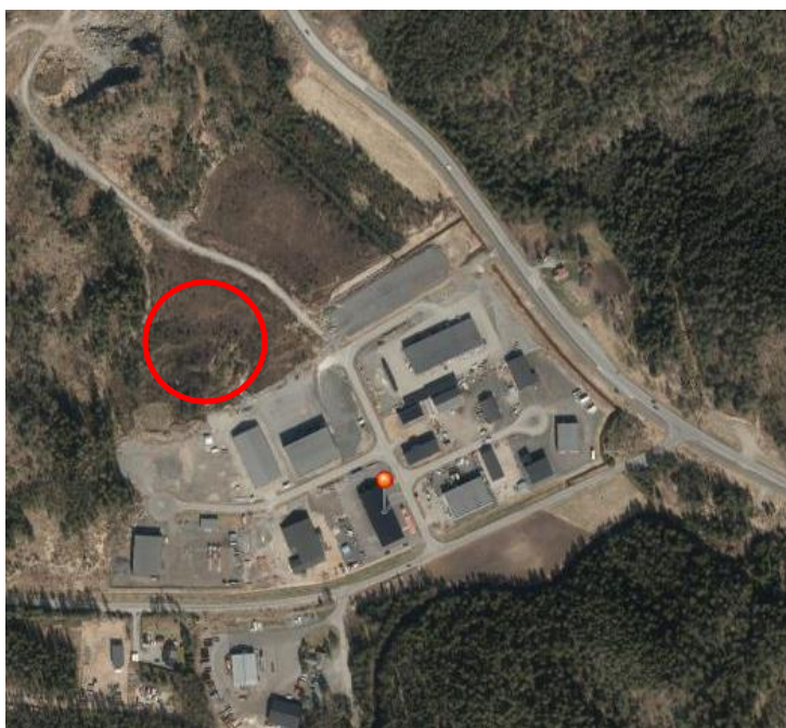
Figur 6. Øverst: Mofimyra før utbygging av Tveide næringspark. En ser tydelig torvuttaket vest i planområdet (rød sirkel). Nederst: Mofimyra etter utbygging. Anleggsvei er etablert over myrområdet. Kilde: norgebilder.no.
