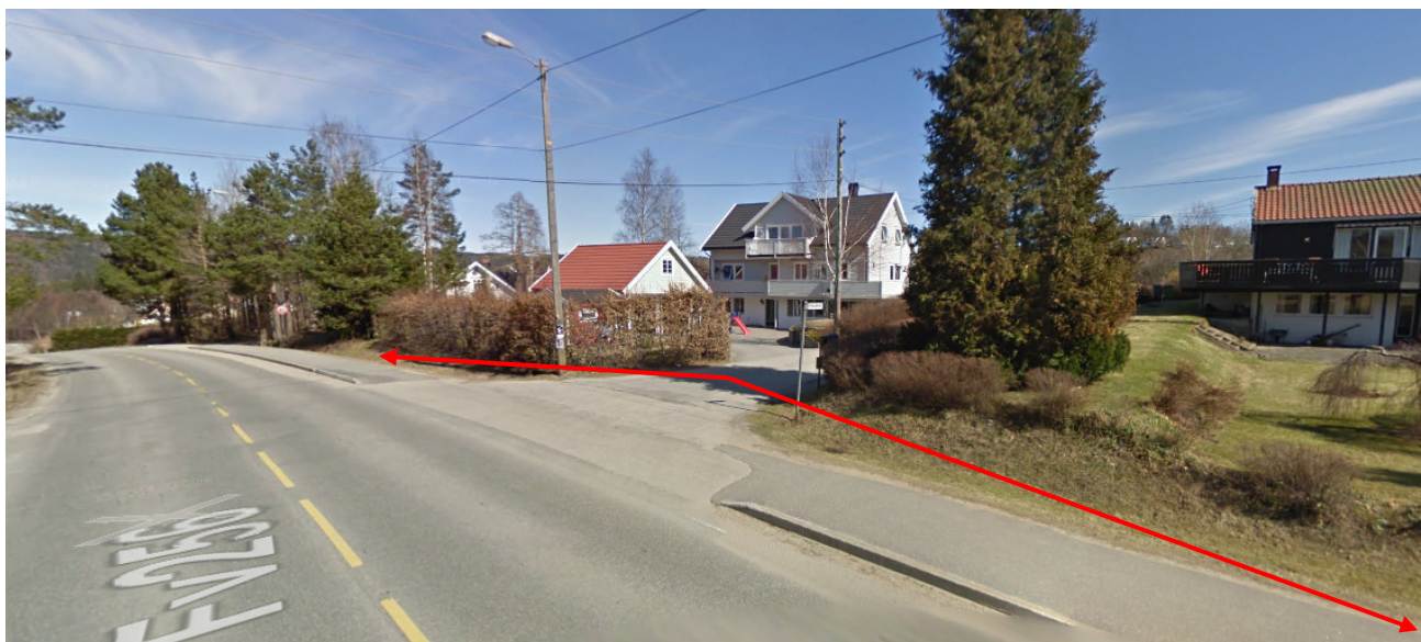
Krysset Hauane/Tveiteveien. Frisiktsone på 4x20m fra Hauane til GS vei er reell per i dag.
